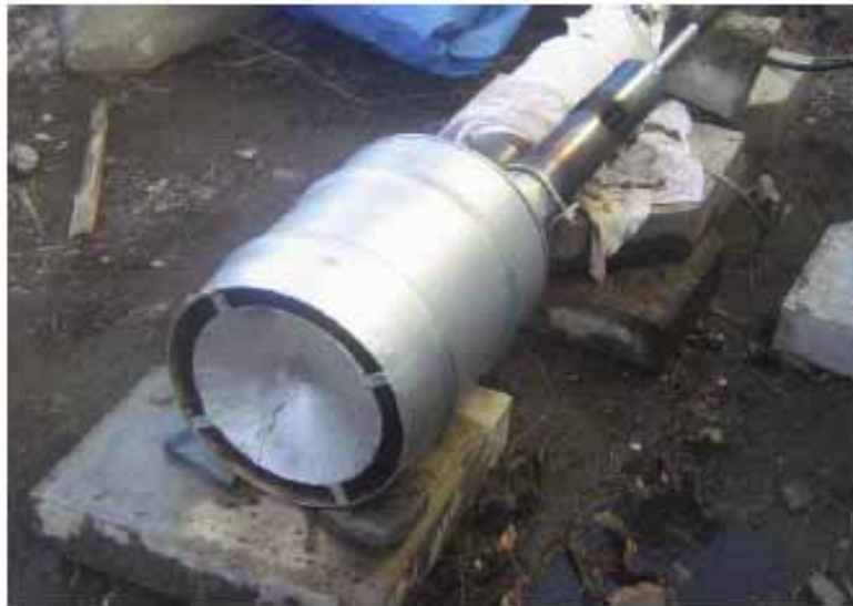
(a) 蒸気みの噴霧 (パイロットバーナー燃焼中)
